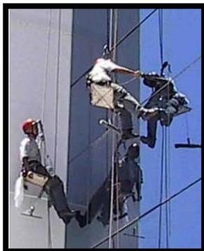
Figura 3 – Redundância na utilização das cordas: de trabalho e de vida, com balancim.
