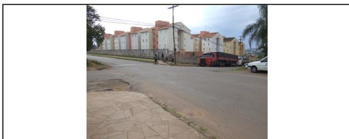
Nas calçadas em locais com faixa destinada à travessia de via pública por pedestre, não há rebaixamento do meio fio e rampa sobre a calçada, desta forma não há faixa de circulação, não tem continuidade de piso e a existência de obstáculos na travessia se dá nas condições da rua e na inexistência de faixa de segurança.
