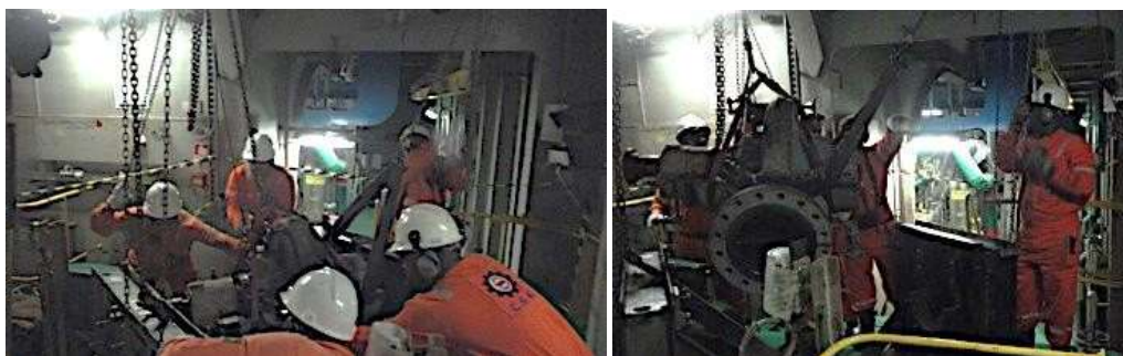
Figura 2 - Remoção do suporte e remoção da bomba do berço
