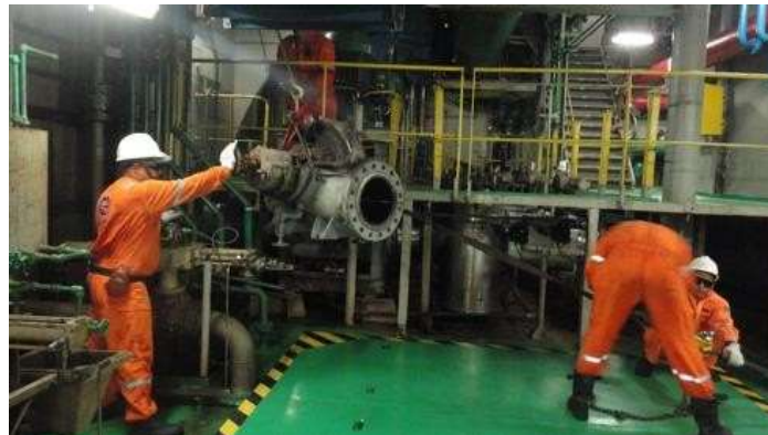
Figura 3 - Usuários puxam a bomba com o tirfor para passar pelas interferências
