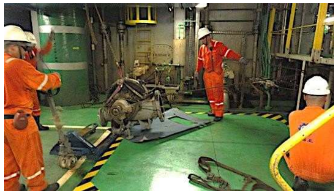
Figura 4 - Usuários montam sistema com talhas e cabos para alocar bomba na paleteira
