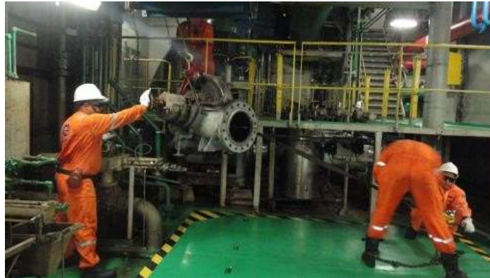
Figura 3 - Los usuarios tiran de la bomba con el neumático para pasar a través de las interferencias
