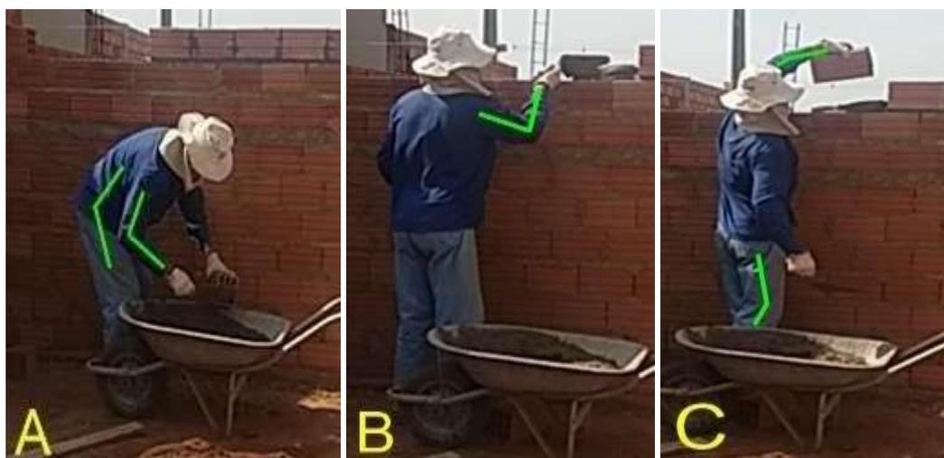
En la Figura 4, el trabajador se encuentra en una posición más vertical en la ejecución de la mampostería, debido a que los muros se encuentran a una altura superior a 1,50 m. Para obtener las puntuaciones del levantamiento superior de albañilería, es necesario analizar las posiciones que ocupa el trabajador en la ejecución de su tarea.
