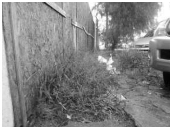
Na figura 3A pode-se observar a falta de pavimentação, dificultando a passagem de qualquer pessoa, seja qual for a sua condição motora. Já no trecho da figura 3B, observa-se que havia pavimento, porém não houve a conservação adequada do mesmo e a vegetação acabou por tomar conta do local. Isto ocorre porque a obra ainda não chegou à etapa de reconstrução do pavimento externo o que impossibilita a utilização do *check-list* nesta parte do projeto.
